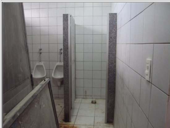
Fig. 07 - Vista do revestimento cerâmico do wc masculino, Bloco S2, Pavimento térreo.
