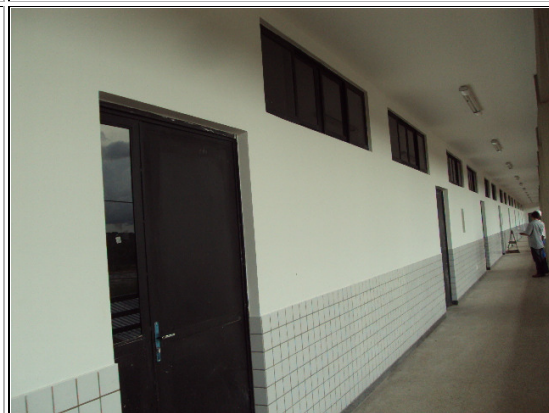
Fig. 04 - Vista do revestimento cerâmico do corredor do Bloco S2, não previsto em projeto.
