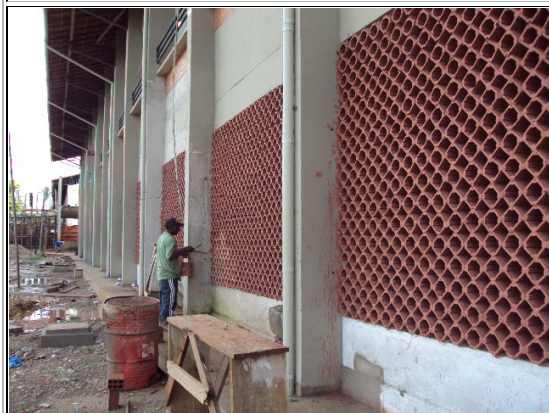
Fig. 03 - Vista do elemento vazado, não existente na planilha orçamentária do Bloco S2.
