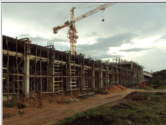
Fig. 02 - Vista da fachada sul do Bloco S4.
