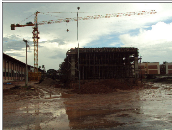
Fig. 01 - Vista da fachada norte do Bloco S4, ao fundo (foto de 23/4/2012), em que se nota o início da elevação da alvenaria, sem chapisco, emboço ou reboco.
