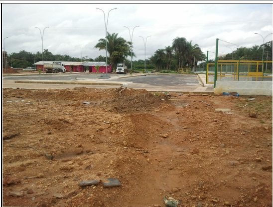
Fig. 08 - Vista do aterro no canteiro entre os estacionamentos do CT.
