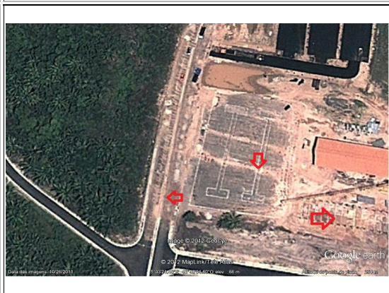
Fig. 04 - Vista aérea da edificação, em 26/10/2011, ou seja, 4 (quatro) meses após a rescisão do Contrato nº 83/2009, via-se somente o arranque de pilares (seta maior a direita).
