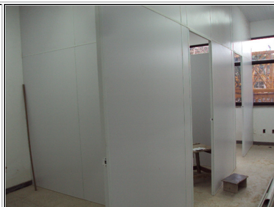
Fig. 02 - Vista da sala de professores, com acréscimo de divisórias e portas.
