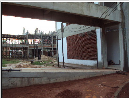
Fig. 01 - Vista da fachada norte do Bloco S4, ao fundo (foto de 23/4/2012), em que se nota o início da elevação da alvenaria, sem chapisco, emboço ou reboco.
