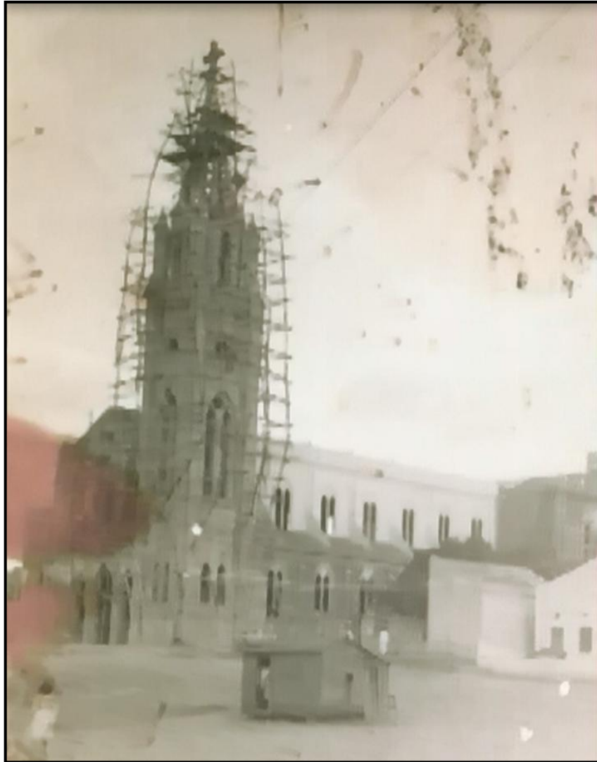
Figura 8 - A Igreja Matriz com sua primeira torre em fase de conclusão, nota-se na imagem a rusticidade dos equipamentos de suporte dos pedreiros.
