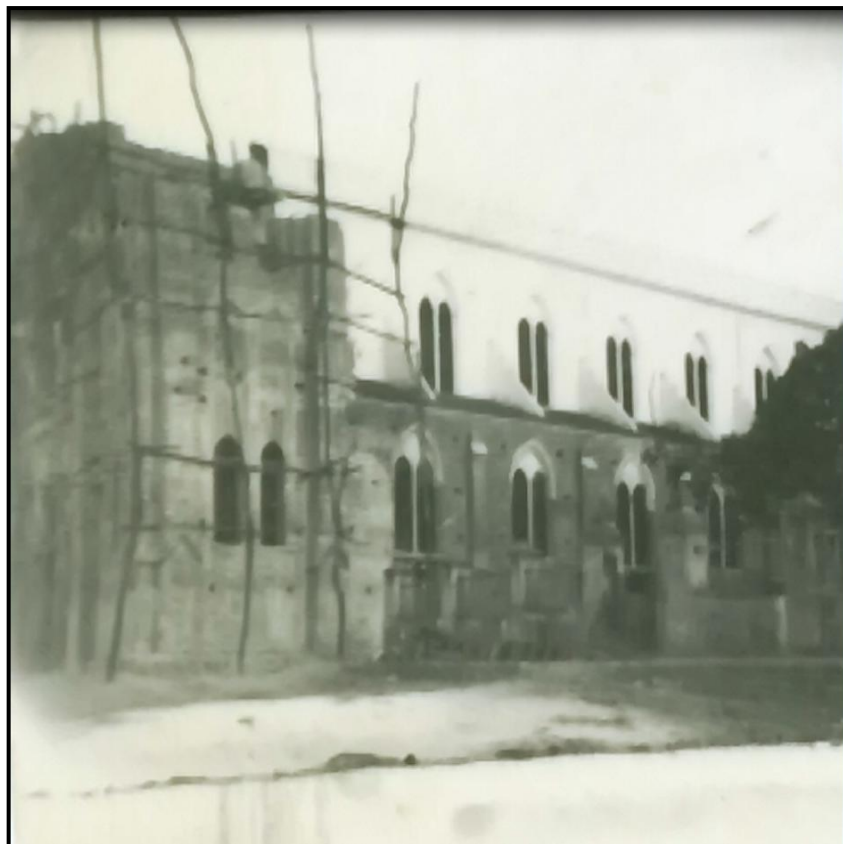
Figura 7 - Imagem do início da construção da nova Igreja, como descreve Oneide Rocha, percebe-se a precariedade e fragilidade dos andaimes.
