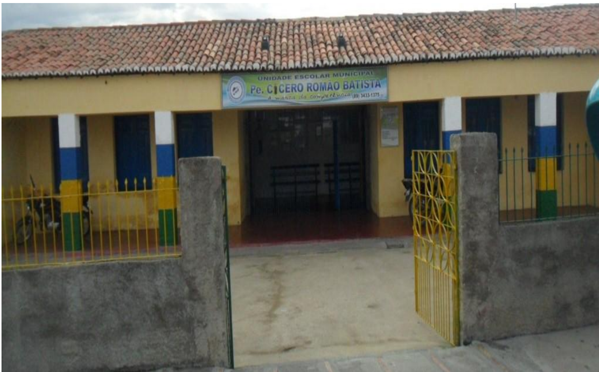
Ilustração 7: Atual Prédio da Escola, fundada em Janeiro de 1983 e funciona até os dias atuais.
