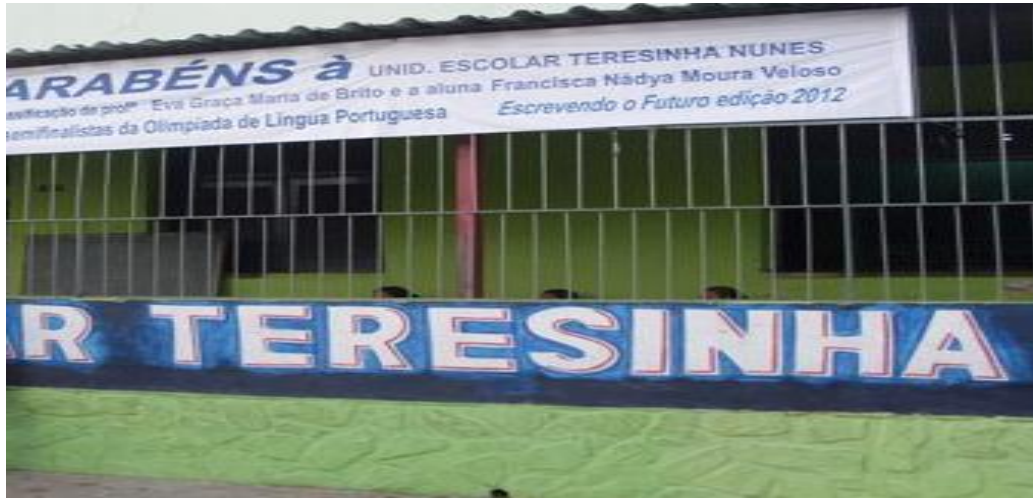
Fotografia 2 – Fachada da Unidade Escolar Teresinha Nunes
