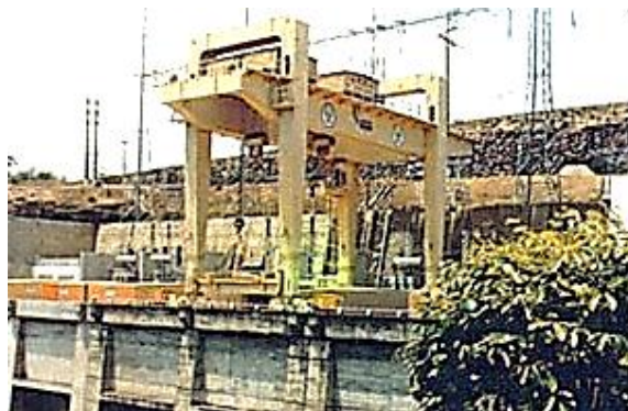
Figura 10: Hidrelétrica Boa Esperança Fonte: http://www.chesf.gov.br . Acesso em 15/02/2014.
