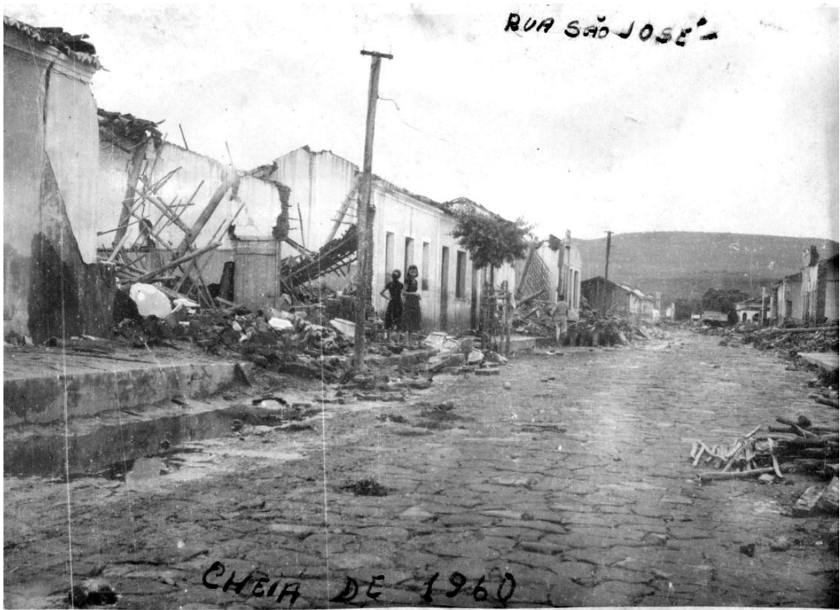
Figura 09: ruas destruídas pela enchente
