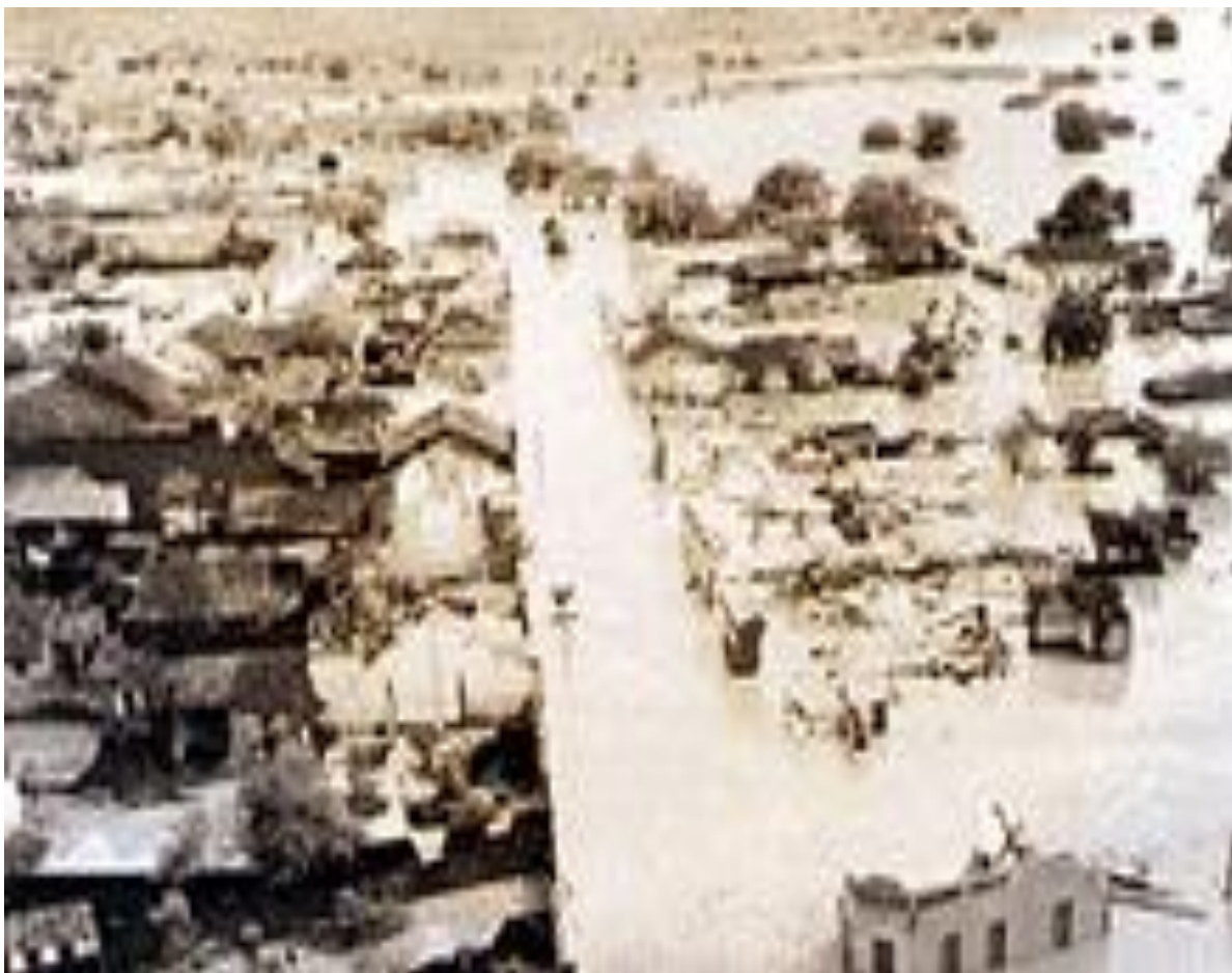
Figura 02: vista da cidade de Picos inundada pela enchente
