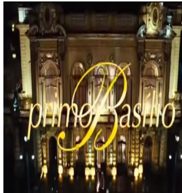
Figura 5. Fachada do Teatro Municipal de São Paulo.
