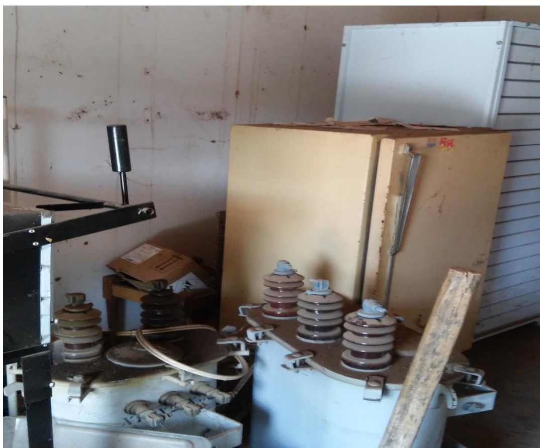
Imagem 02: Depósito onde a prefeitura de Santana do Piauí guarda os materiais desnecessários. FONTE: Arquivo pessoal de João Mateus Leal. Tirada em 06/05/2016.
