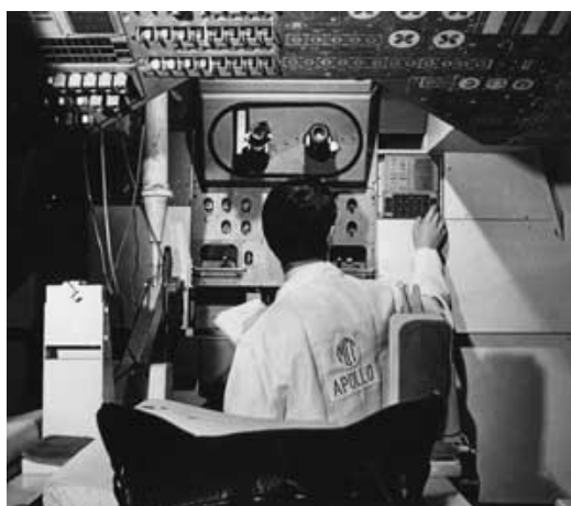
Figura 2: Engenheiro checando o Apollo Guidance Computer em um laboratório no MIT
