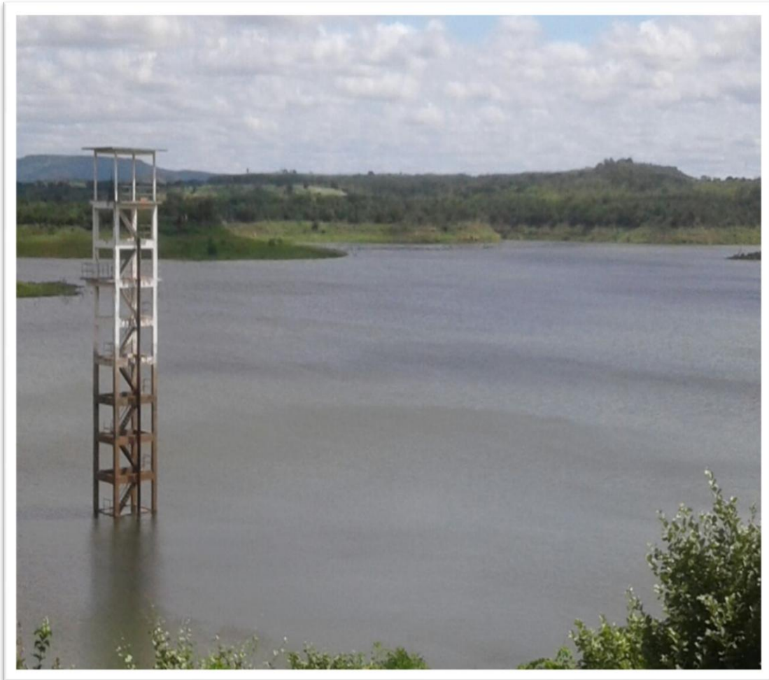
Figura 7: vista do açude bocaina. 10/04/2018.
