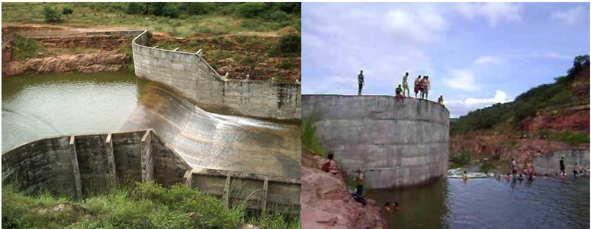
Figura 10: sangradouro da barragem de Bocaina.
