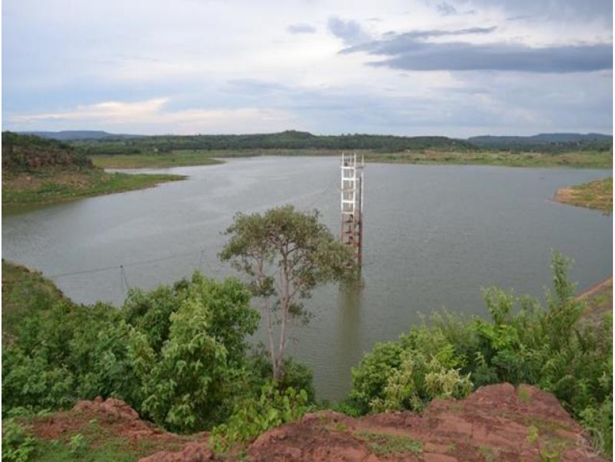
Figura 8: imagem da barragem Bocaina.
