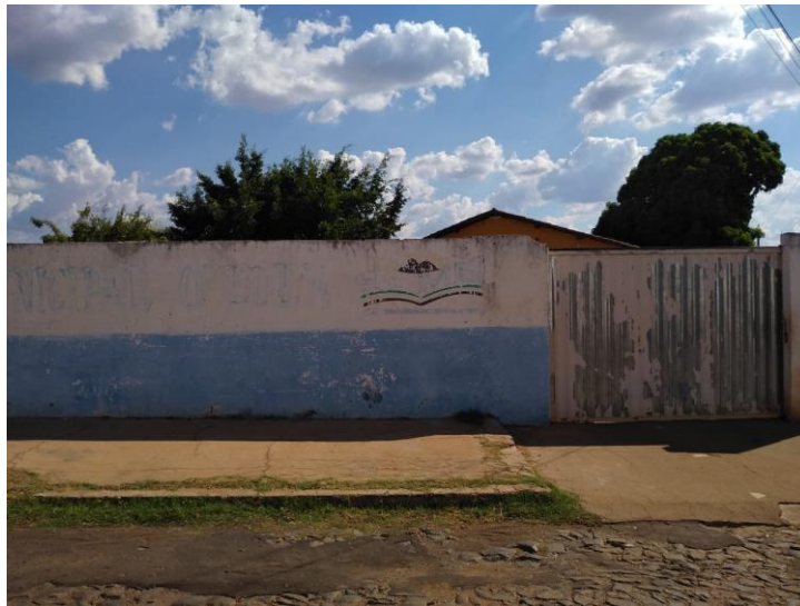
Figura 1 – Vista da frente da escola municipal “O Éden”.
