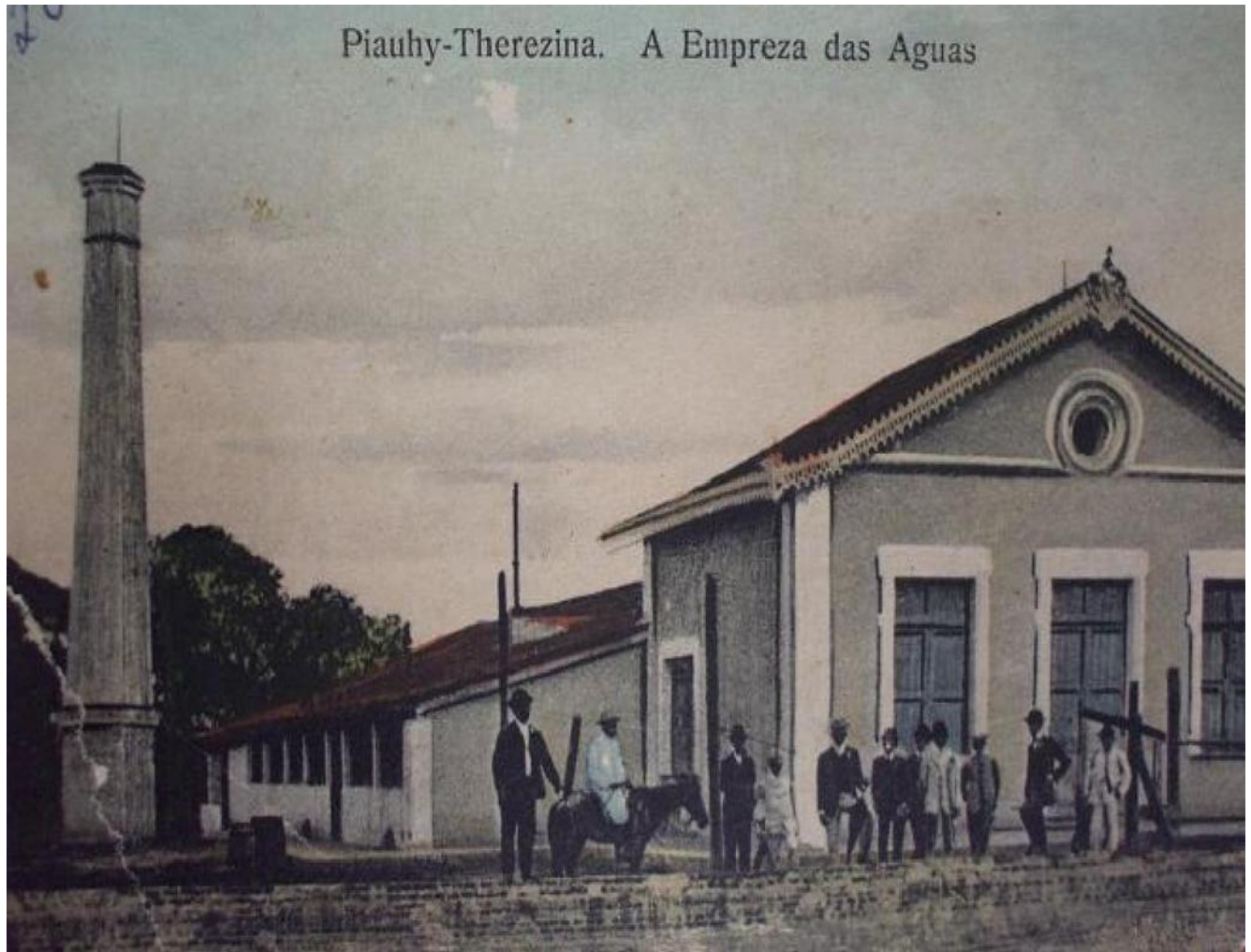
Figura 01: usina elevatória de águas em Teresina.
