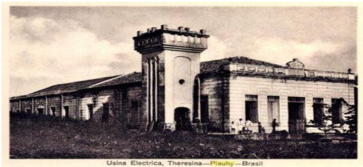
Figura 03: Usina elétrica de Teresina.
