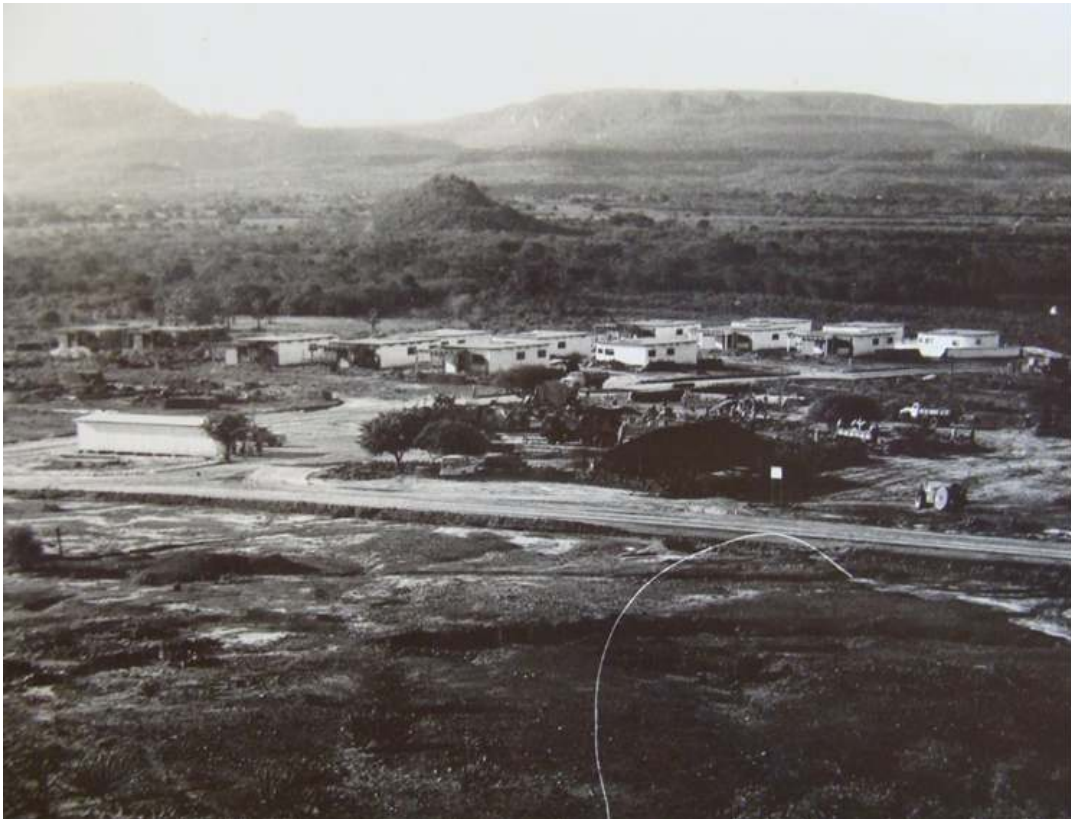
Imagem 09: Construção do prédio do 3º BEC
