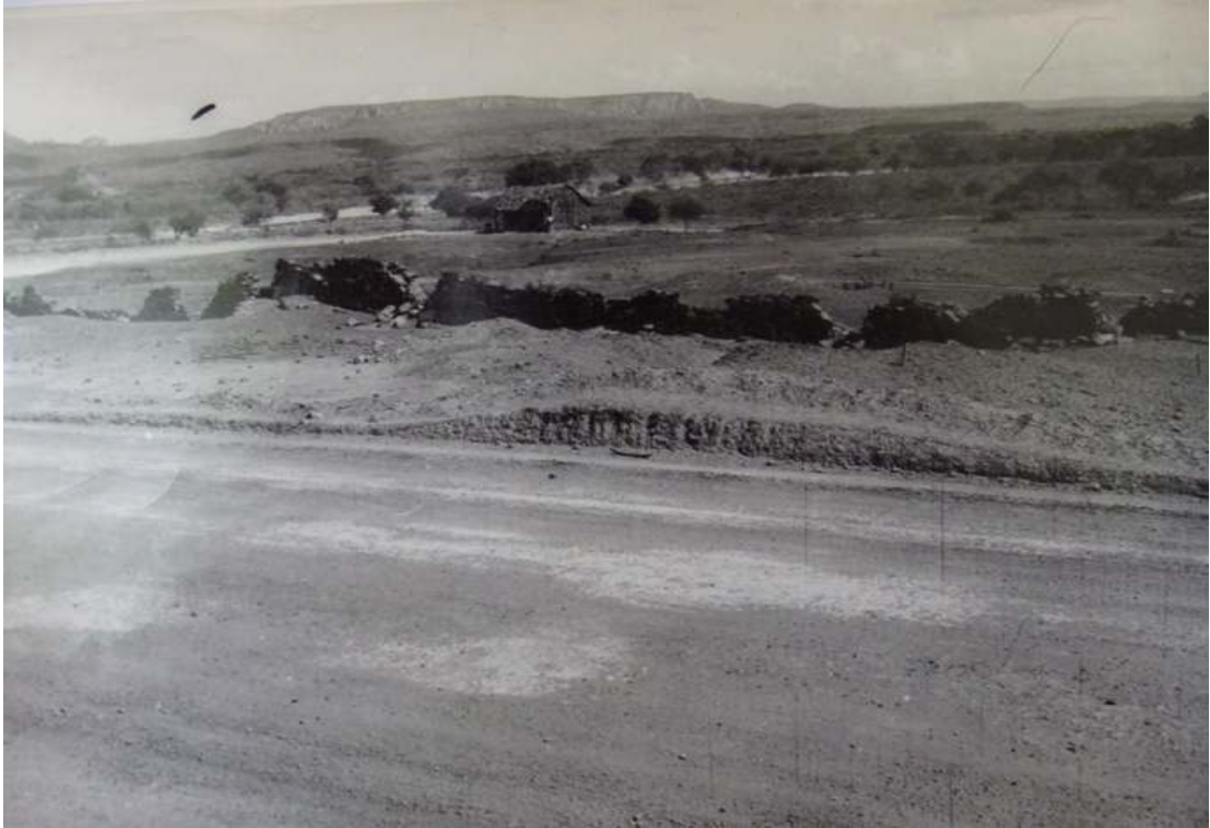
Imagem 05: Local escolhido para a construção da sede do 3º BEC.
