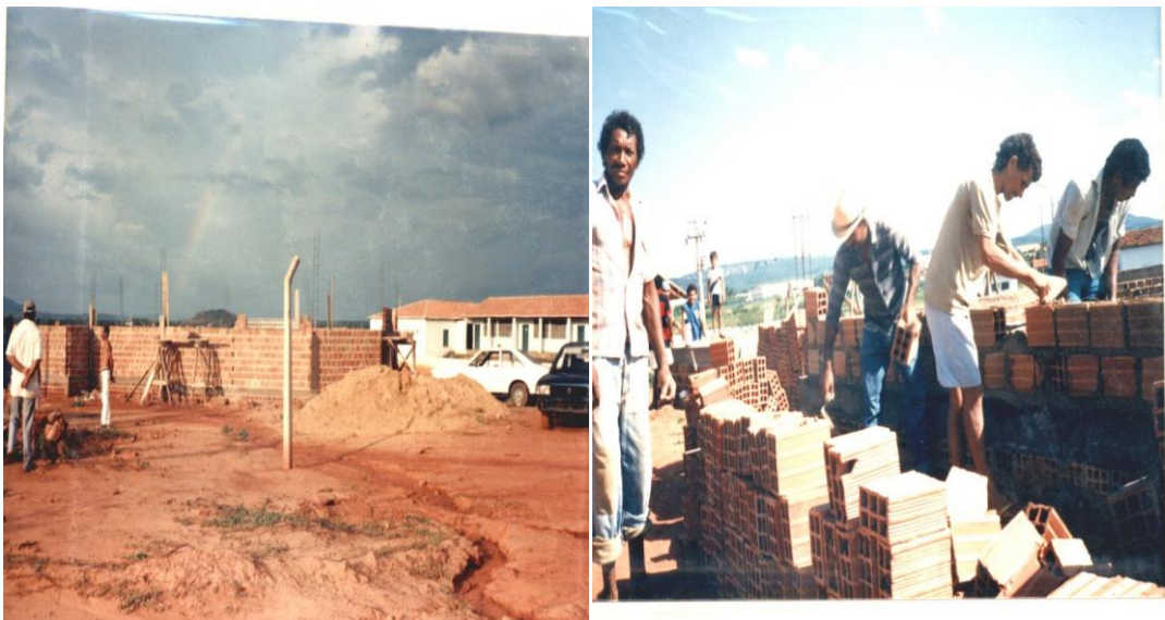
Figura 6- Construção do Centro de Estudos e Assistência Espiritual
