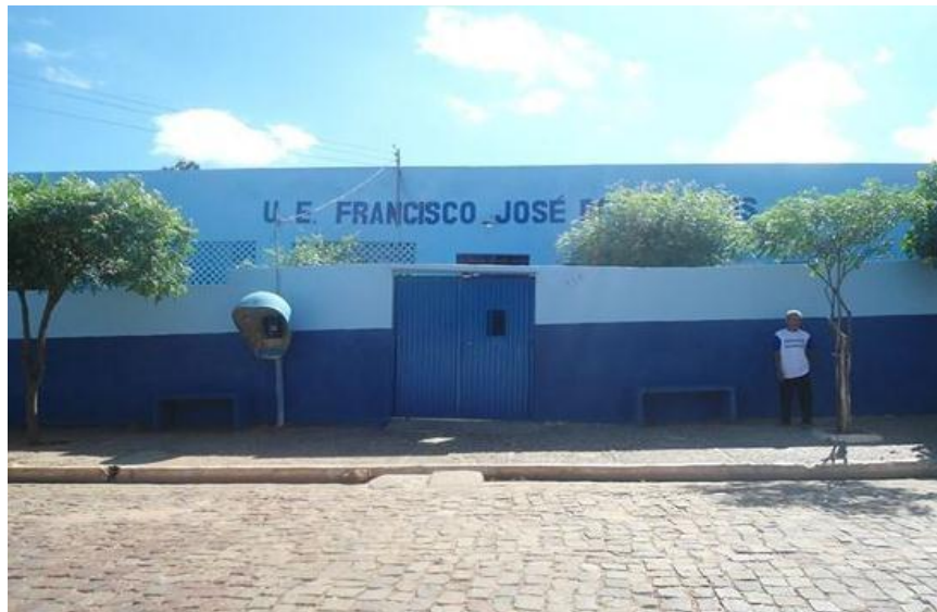
Figura 6 - Unidade Escolar Francisco José dos Santos Fonte: http://radardobrasil.com/portal/category/municipios/page/2/
