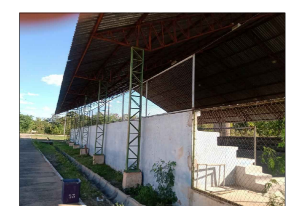
Imagem: Pilares e estrutura de coberta da quadra ACERVO PRELIM
